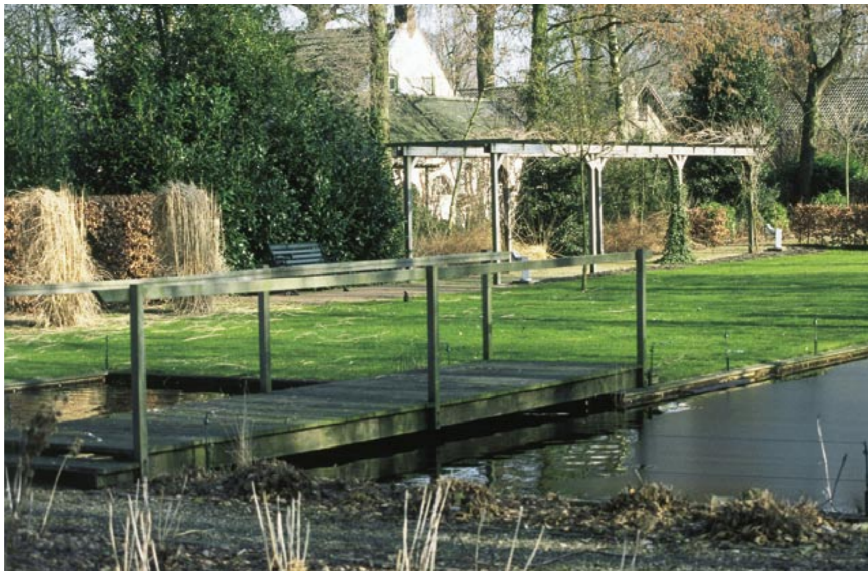
Schaduwterras bij de vijverpartij in het midden van de tuin. De vijver is vervaardigd van folie dat aan hardhout is bevestigd.
